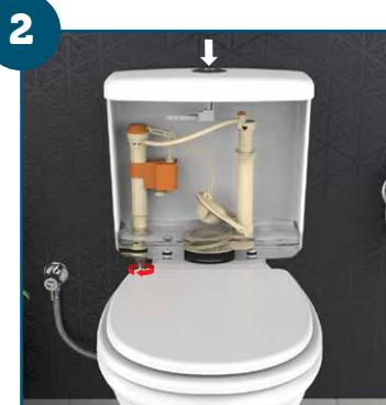
Esvazie a caixa de descarga (se necessário, limpe o interior da caixa) e desrosqueie a ligação flexível conectada ao mecanismo de entrada.
