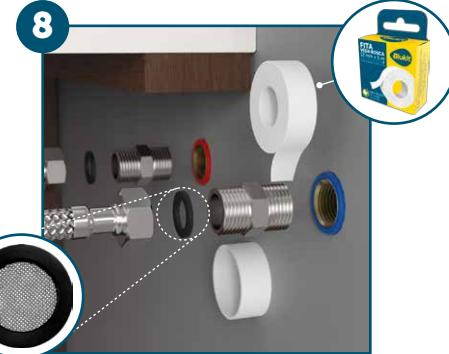
Aplique de 5 a 8 voltas de fita veda rosca **Blukit de 12 mm** em uma das extremidades dos nípates de modo que cada volta avance cerca de 0,5 cm em relação a volta anterior. Rosque-os nas tomadas d'água na parede e, a seguir, rosque as extremidades fêmeas das ligações flexíveis nos nípates.
