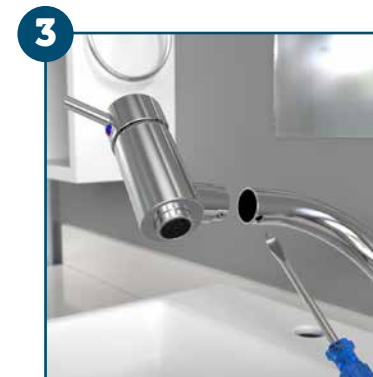
3 Solte o parafuso e desacople a bica. Afije el tornillo y desconecte el punto de salida.
