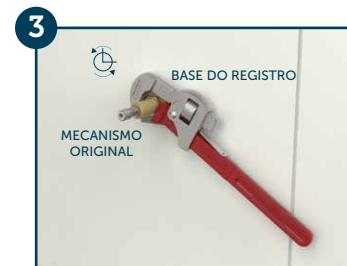
3 Com uma chave de cano (grifo), retire o mecanismo do registro defeituoso da parede.
