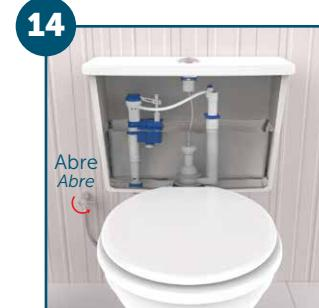
Reabra a válvula de alimentação da caixa de descarga.
